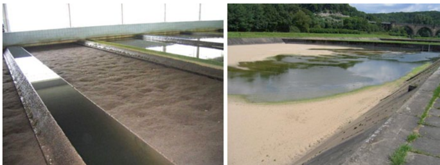
Abb. 6.2 ( links ) Foto eines trocken gefallenen offenen Schnellfilters sowie ( rechts ) eines Langsandsfilters im Verbundwasserwerk Witten zur Grundwasseranreicherung im Ruhrtal
