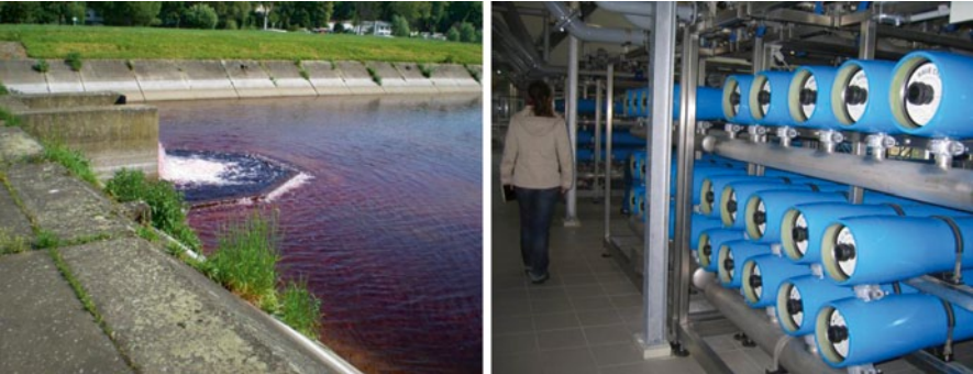
Abb. 6.5 (links) Kaliumpermanganatzugabe in ein Schnellfilterbecken einer Wassergewinnung im Ruhrtal; (rechts) Foto einer Umkehrosmoseanlage (Wasserwerk Löhnen der Stadtwerke Dinslaken)
