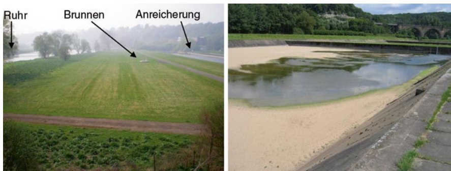
Abb. 8.2 Ruhr mit Brunnen und gefluteten Langsandsfiltern („Anreicherung“) im mittleren Ruhrtal ( links ); Detailansicht eines Langsandsfilters ( rechts )
