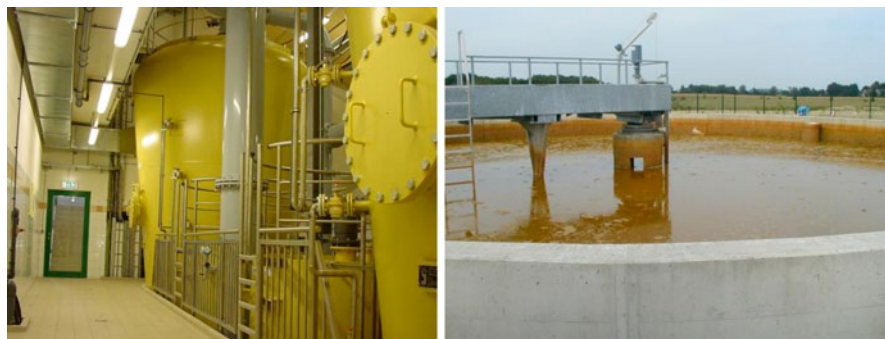
Abb. 6.4 (links) Foto der Entcarbonisierungsreaktoren und (rechts) des Räumbeckens, das das Filterrückspülwasser von Enteisungsfiltern aufnimmt, im Wasserwerk Liedern der BEW in Bocholt
