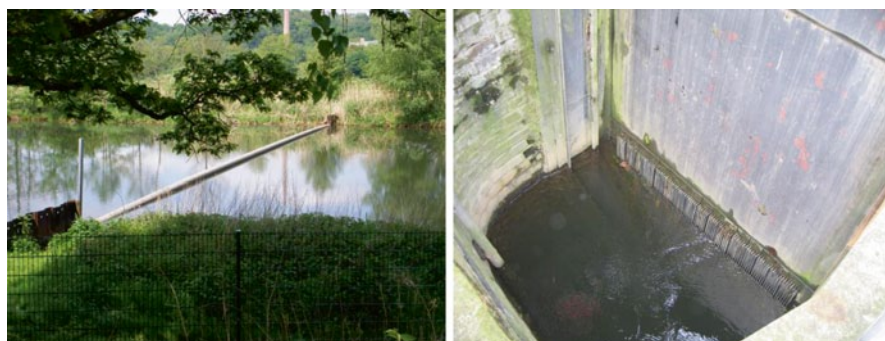
Abb. 6.1 (links) Foto einer Ölsperre im Sedimentationsteich (Absetzteich) des Wasserwerkes Essen-Burgaltendorf der WEG; (rechts) Foto eines Feinrechs im Zulauf des Verbundwasserwerkes Witten
