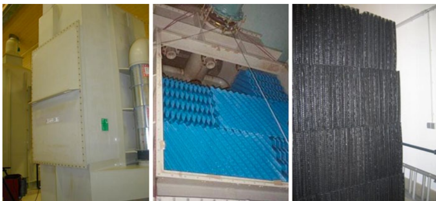
Abb. 6.3 ( links ) Foto eines geschlossenen Rieslers (NVV, Mönchengladbach) und ( Mitte ) des inneren Aufbaues eines geöffneten Rieslers zur Strippung oder Belüftung von Wasser (Verbundwasserwerk Witten) sowie ( rechts ) alternative Füllkörper
